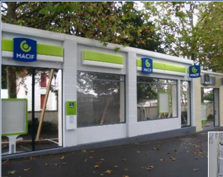
Façade d'agence test MACIF
