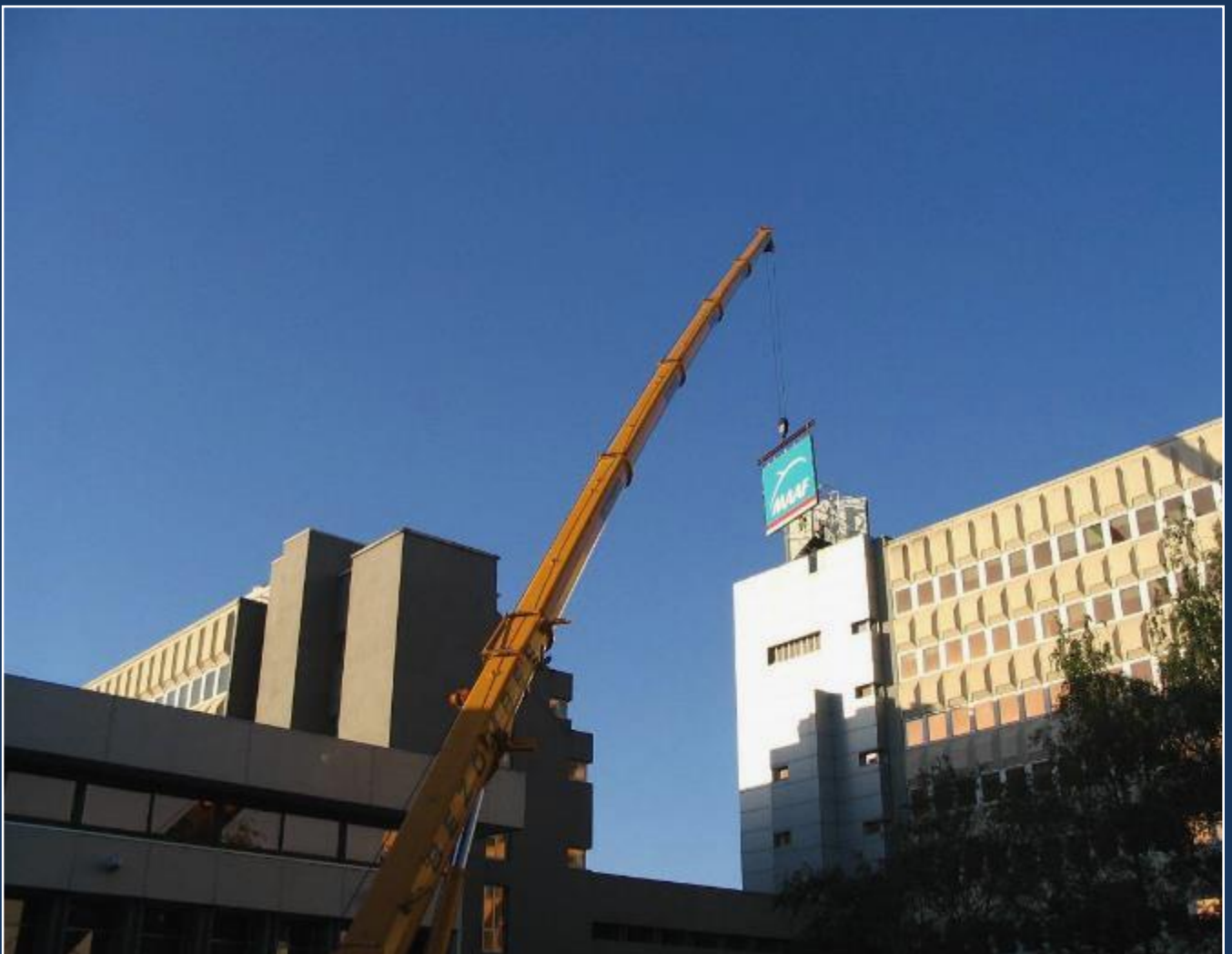
Nouvelle enseigne de toiture, siège de MAAF, Niort
