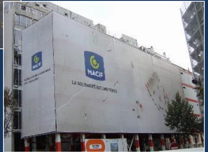
Bâche de chantier nouveau siège social MACIF, Paris
